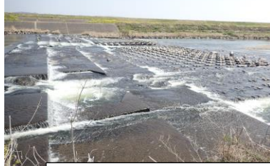
4月12日 久慈川堅磐堰の様子
