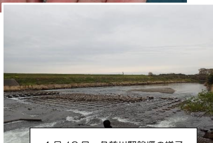
4月13日 久慈川堅磐堰の様子
