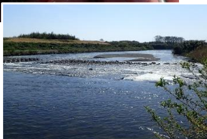
4 月 10 日 久慈川堅磐堰の様子
