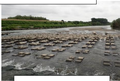
5 月 30 日 久慈川堅磐堰の様子
