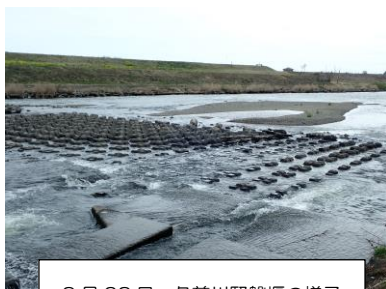
3月23日 久慈川堅磐堰の様子
