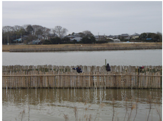
保護柵の設置
