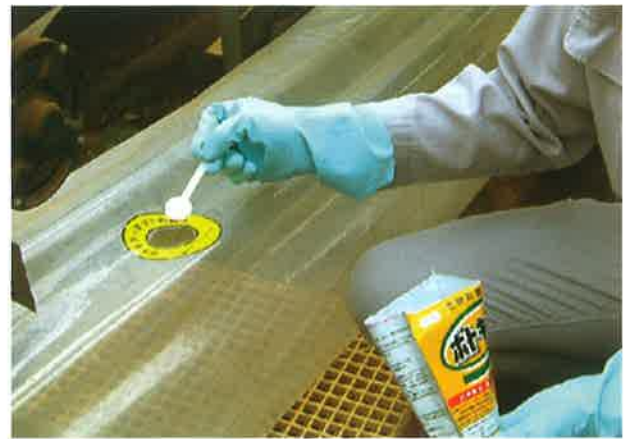
ダクト内投入風景
