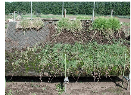
施工 3 ヶ月後（傾斜 30°）
