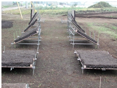
施工直後（平成 14 年 5 月）
