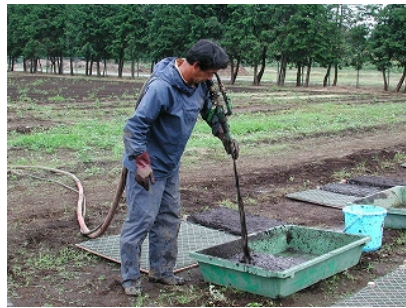
吹き付け作業
