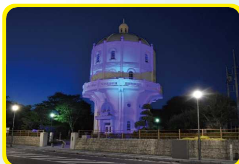
水戸市水道低区配水塔
