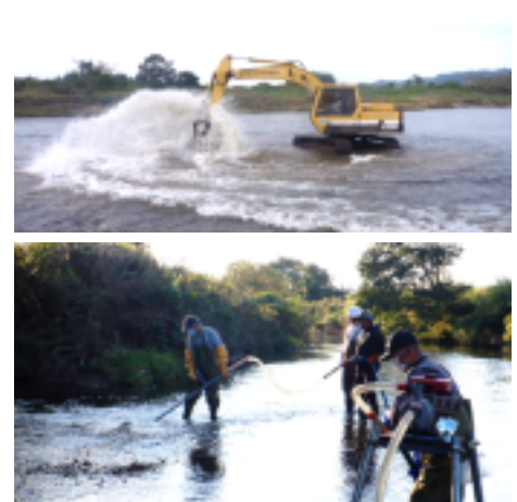
【図3】重機による産卵場造成（上）と小型エンジンポンプ式産卵場造成（下）
