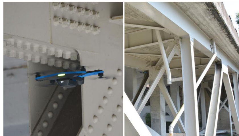
橋梁下部の点検をドローンで行う様子
