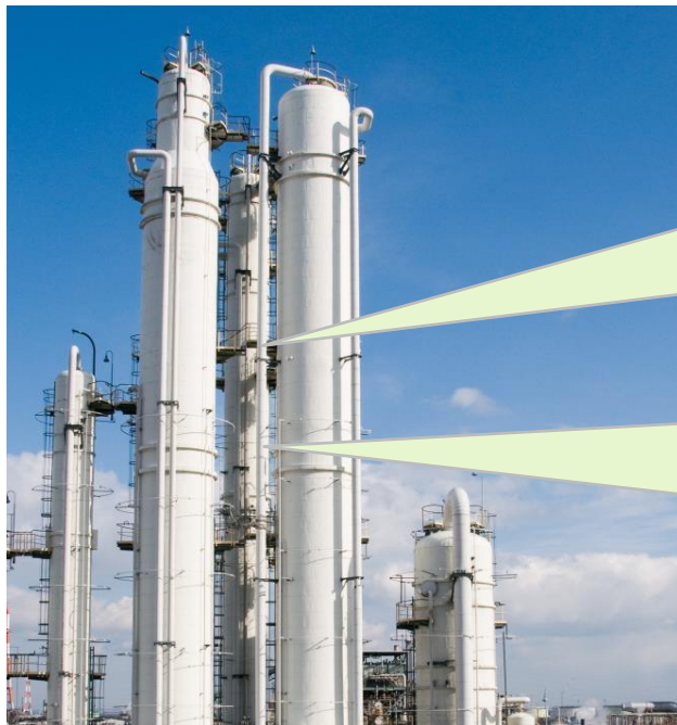
AI自動制御システムを導入したブタジエン生産プラント
