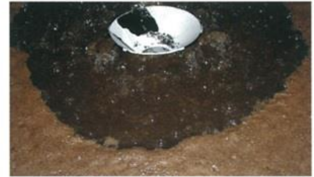
ろ材の空気洗浄状況
