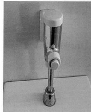
図3 男性用小便器の水洗のための押しボタン
