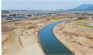
川幅を広げる河道掘削工事(桜川・つくば市)
