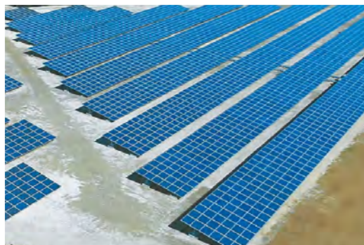
設置が進む太陽光発電施設
