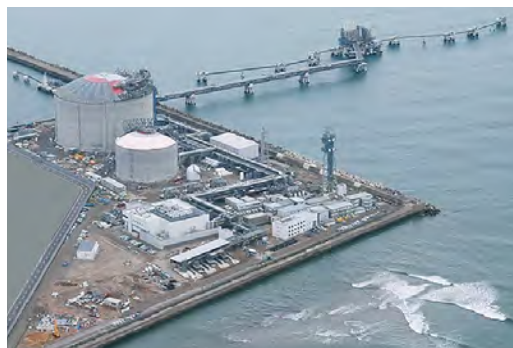
3月に供用開始されたLNG基地(茨城港日立港区)
