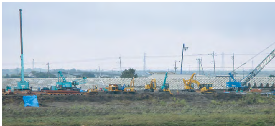
鬼怒川の応急復旧工事の様子(9月18日現在)
