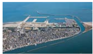
津波対策が必要な利根川下流域(神栖市)
