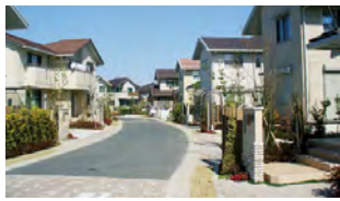
陽光台のまち並み(つくばみらい市)
