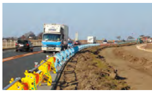
国道294号の四車線化工事(筑西市)
