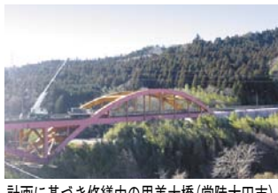
計画に基づき修繕中の里美大橋(常陸太田市)
