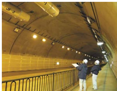
トンネル点検の様子(梅香トンネル:水戸市)
