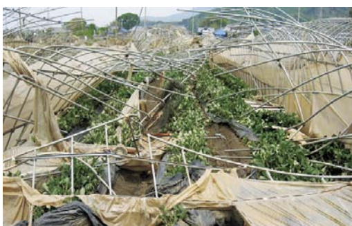
倒壊したパイプハウス(つくば市)
