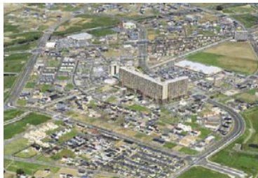
伊奈谷和原地区の整備状況(つくばみらい市)
