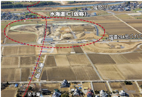
整備の進む圏央道(水海道IC(仮称)) 写真提供:国土交通省常総国道事務所
