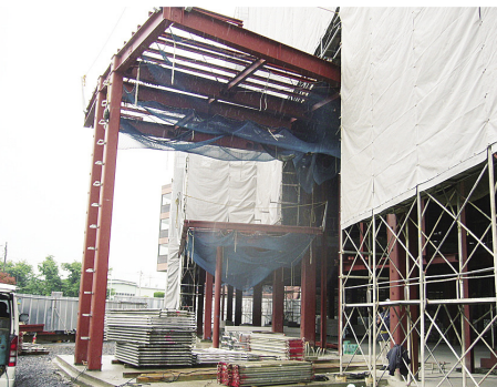
国の交付金を活用した病院の耐震化工事の様子
