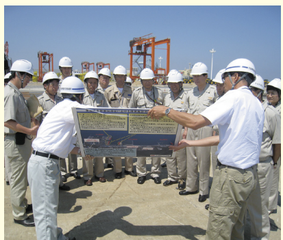
現地調査で被災状況の説明を受ける委員(茨城港常陸那珂港区)
