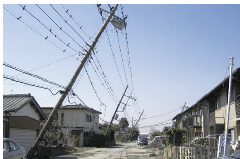
液状化の被害を受けた住宅街(潮来市)
