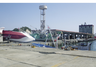
津波被害を受けた大津漁港(北茨城市)
