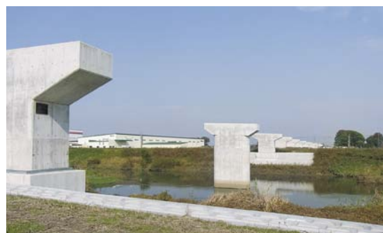
建設が進む圏央道(五霞町幸主地区)
