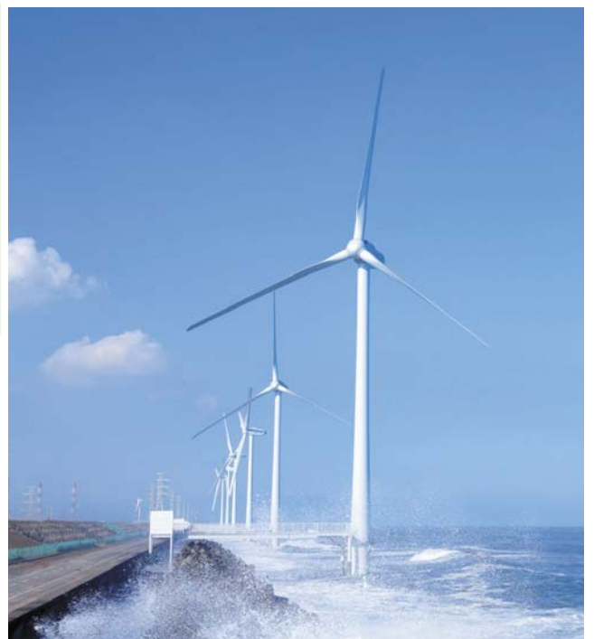
国内初の外海洋上風力発電所 (写真提供：(株)ウインド・パワー・いばらき)
