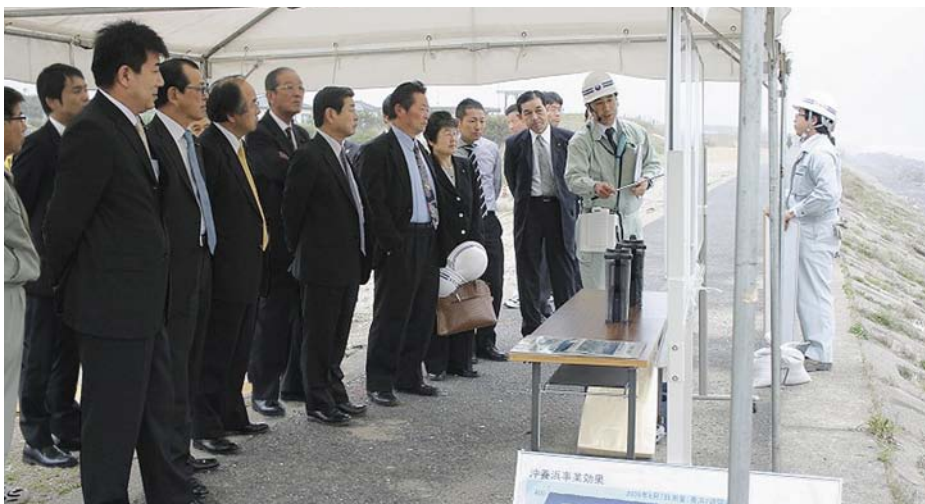
鹿嶋海岸にて、粗粒材による養浜工事の実施状況を調査
