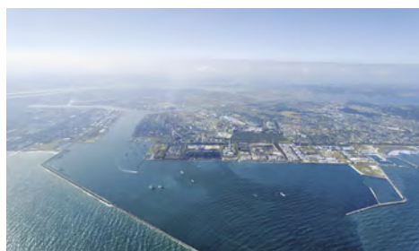
水深14メートル岸壁の建設が進む鹿島港
