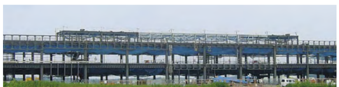
整備の進む茨城空港ターミナルビル
