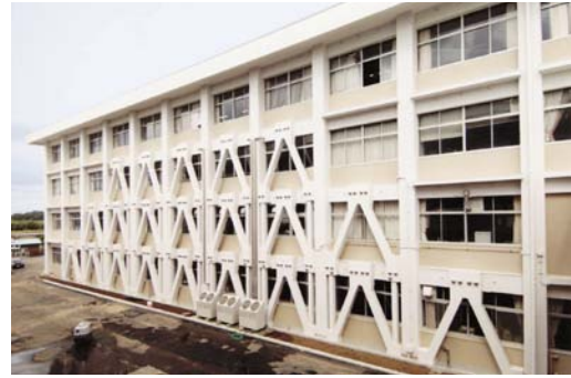
耐震補強工事実施済みの県有施設
