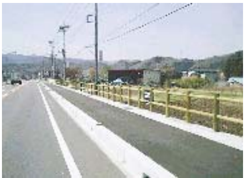
間伐材を利用した歩道転落防止柵
