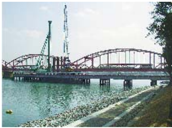
建設中の湊大橋
