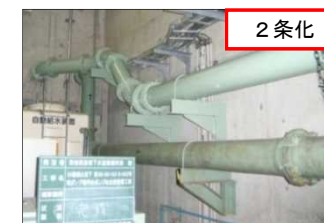
管渠の2条化（霞ヶ浦水郷流域）
