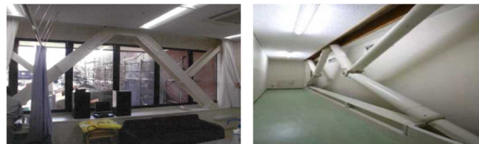
<大規模建築物の耐震改修（イメージ）>
