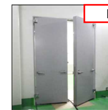
ポンプ場電気室の浸水対策 (鬼怒小貝流域)
