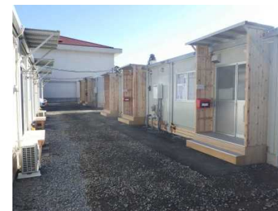
<建設型応急住宅（大子町）>
