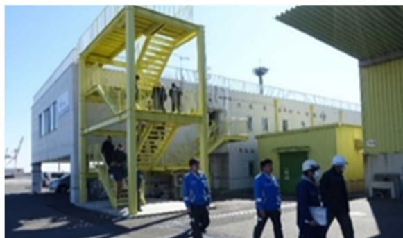
民間施設屋上（常陸那珂港区）
