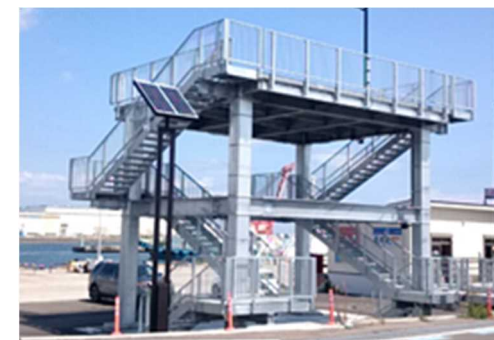
津波避難タワー（日立港区）
