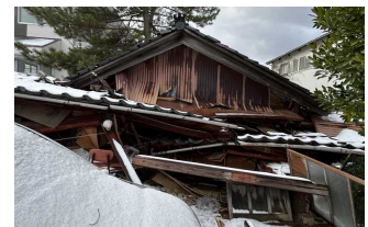
地震による木造住宅の被害
