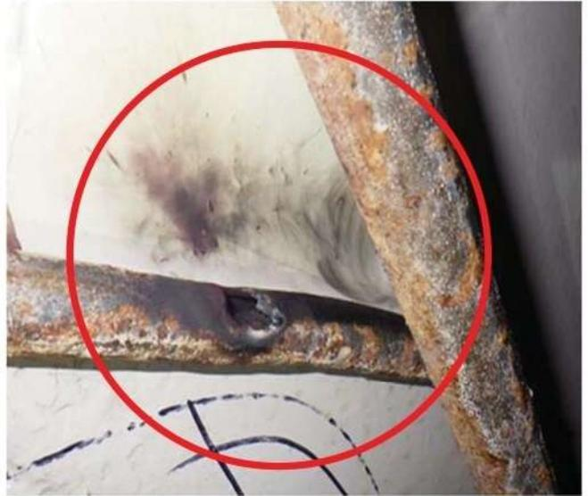
左図拡大図：電線管に穴を確認
