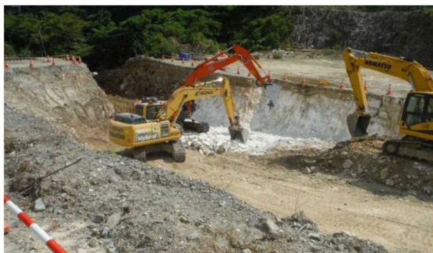
整備地(日立市諏訪町地内)：令和6年8月9日撮影
