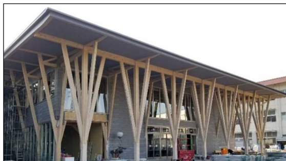
大子町新庁舎（建築中） 純木造大規模建築物
