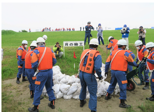
水防団による水防工法訓練（月の輪工）
