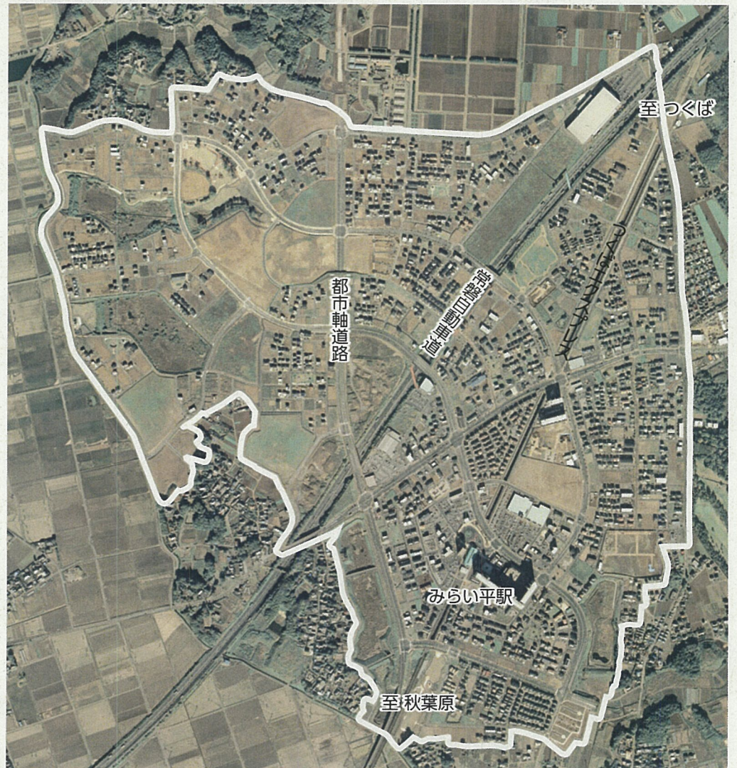
整備後 ～平成25年11月～
