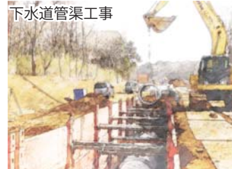
下水道管渠工事
