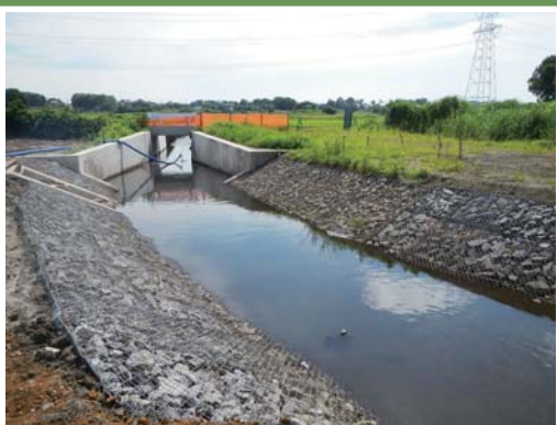
③西谷田川支川の河川改修工事の様子
