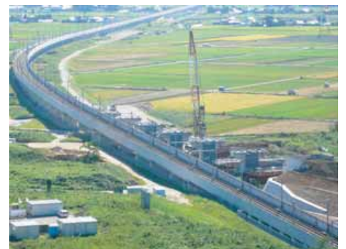
↑ 会場の近くで工事をしている（仮称）伊奈・谷和原高架橋工事現場の見学会を行います。
