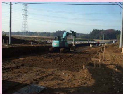
① つくば真岡線バイパスにつながる道路工事の様子
