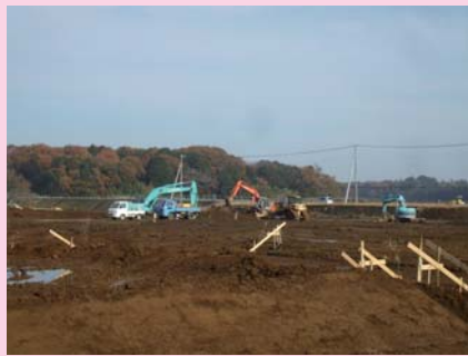
③ つくば真岡線バイパス西側の宅地造成工事の様子
