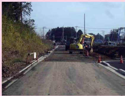
② つくば真岡線バイパスに接続する道路工事の様子
