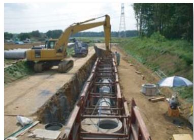
③下水道開削工事の様子
