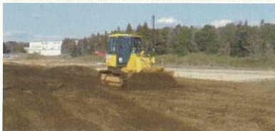
ICT 技術を活用した工事の様子
