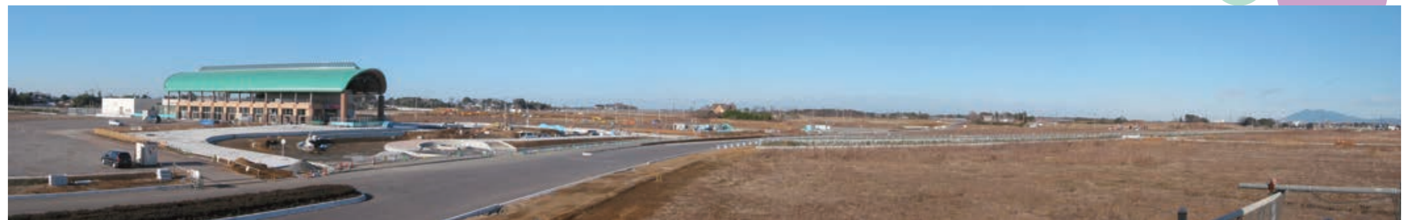
▲ 駅前広場建設中の駅周辺の様子（平成17年1月）
