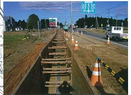
▲供給処理施設の敷設工事 (追原・久野線)
