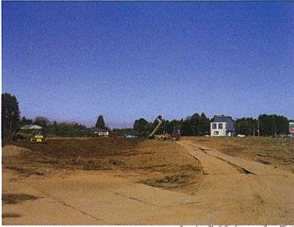
▲北側街区の造成工事
