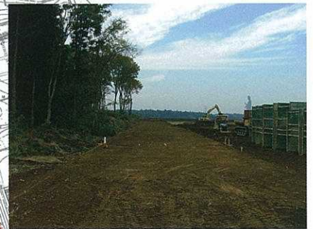
▲道路築造工事 (南側区画道路)
