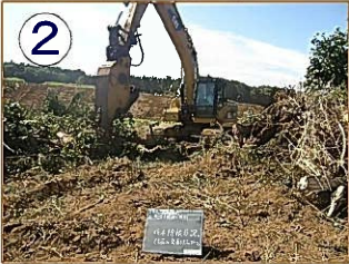
造成工事(伐開工事)
