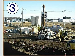
地盤改良工事(町道0207号線)
