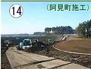
近隣公園整備工事
