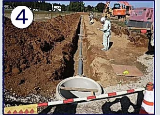
下水道工事(赤太郎通り線)
