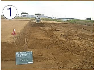
造成工事(宅地整備工事)
