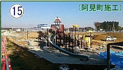
近隣公園遊具設置工事
