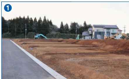
区画道路築造 (1、2、4街区周辺)
