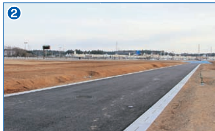
区画道路築造 (16、17、18、24街区周辺)
