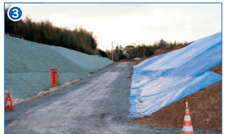
区画道路築造 (41、42、43街区周辺)
