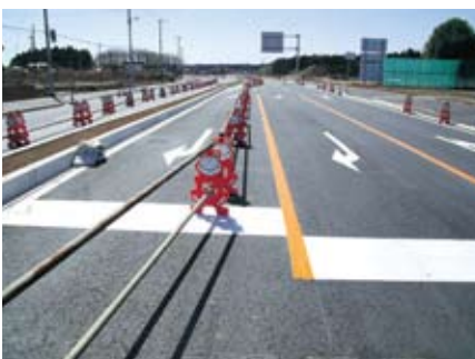
▲着々と進む追原・久野線4車線化工事
