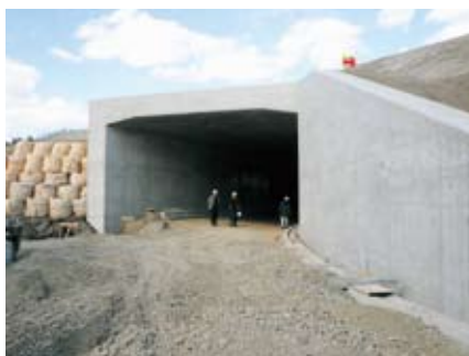
▲完成した『ダイレクトアクセス吉原トンネル!』
