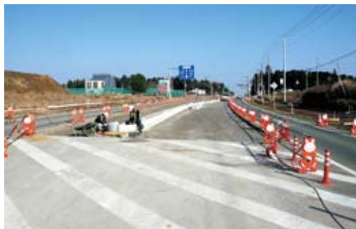
▲追原・久野線4車線化工事
