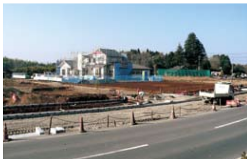
▲堀尻通り線沿道街区造成工事
